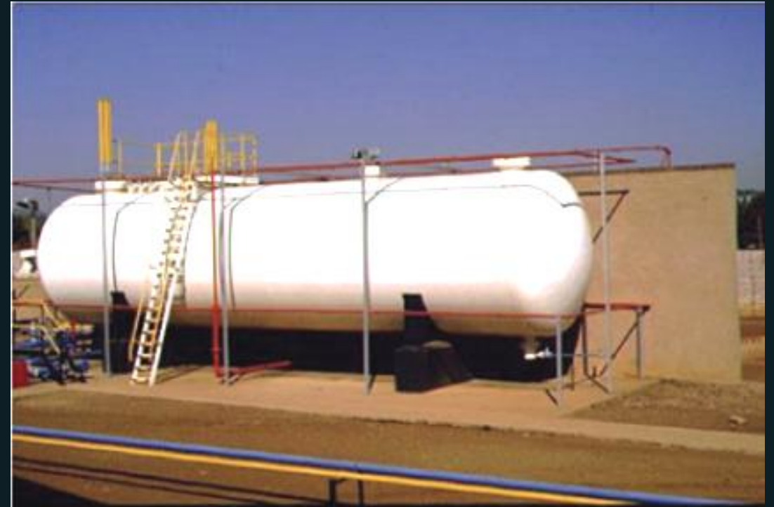
Gambar Penampungan Air
