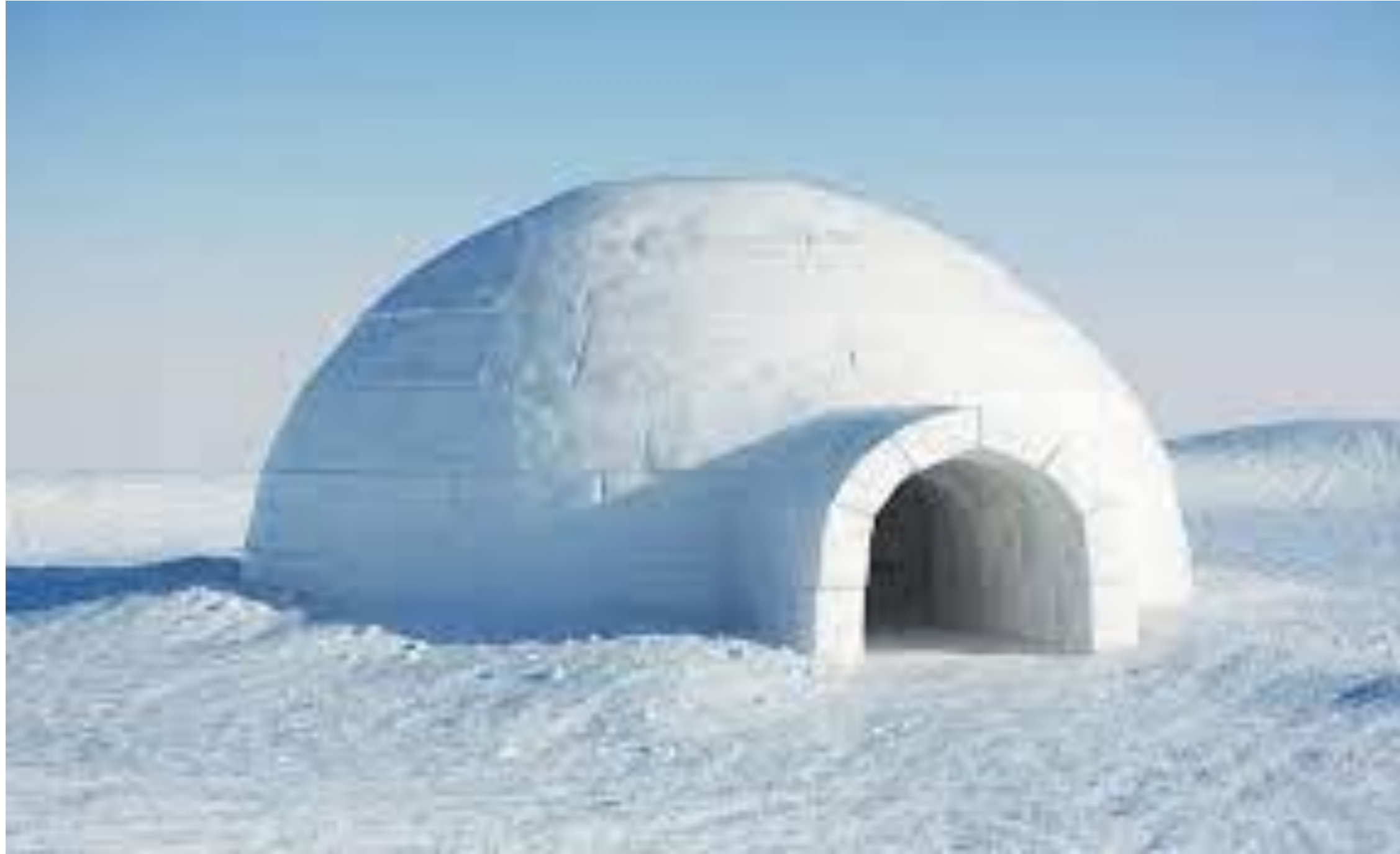
Igloo; Struktur yang lapisan permukaannya sekaligus berfungsi sebagai pendukung
