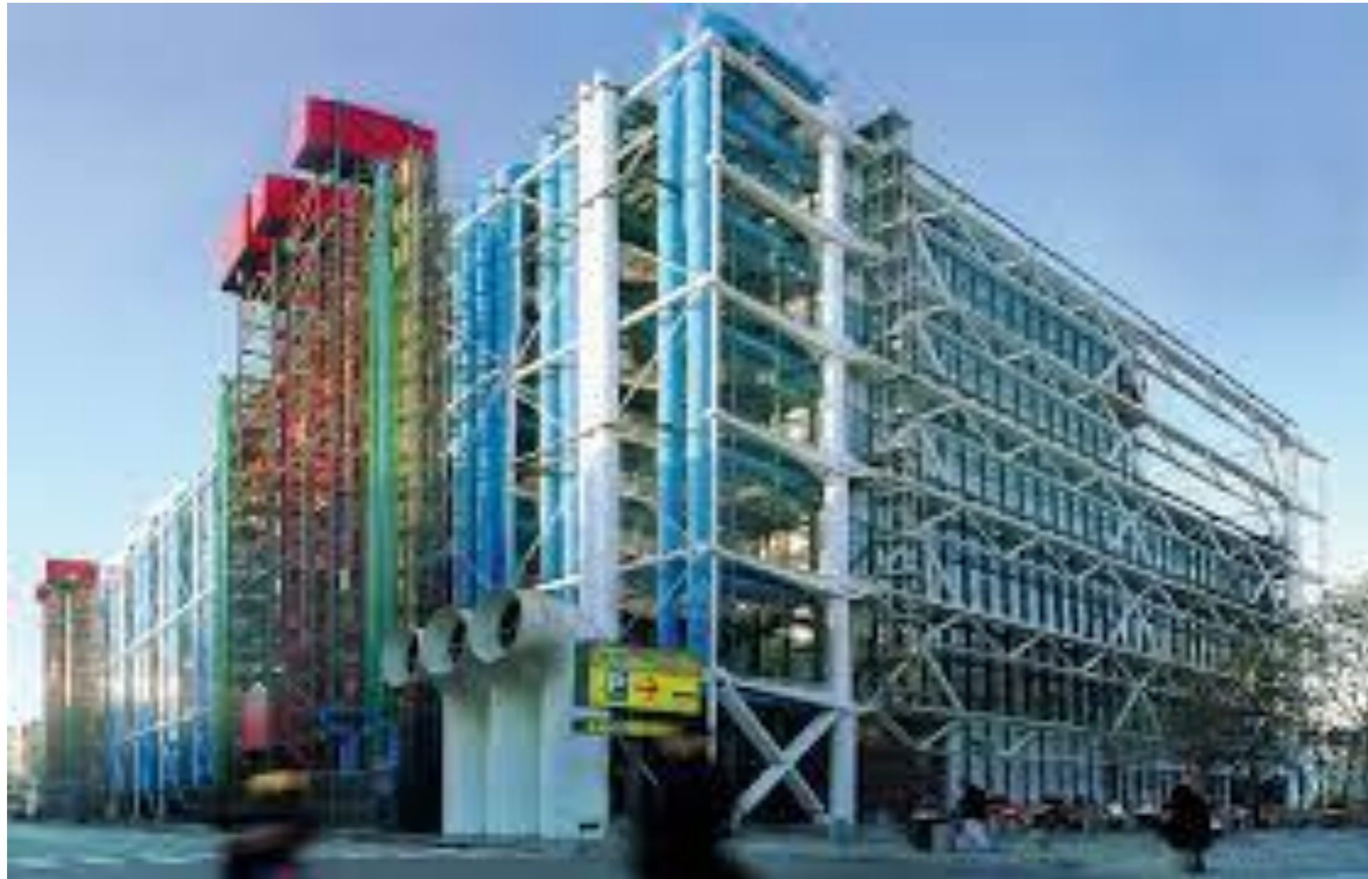
Centre Popidou, Paris, Perancis, 1977, Arsitek, Piano & Rogers. Pemisahan Struktur dan Pembatasan Fungsi elemen sangat terlihat dengan jelas.
