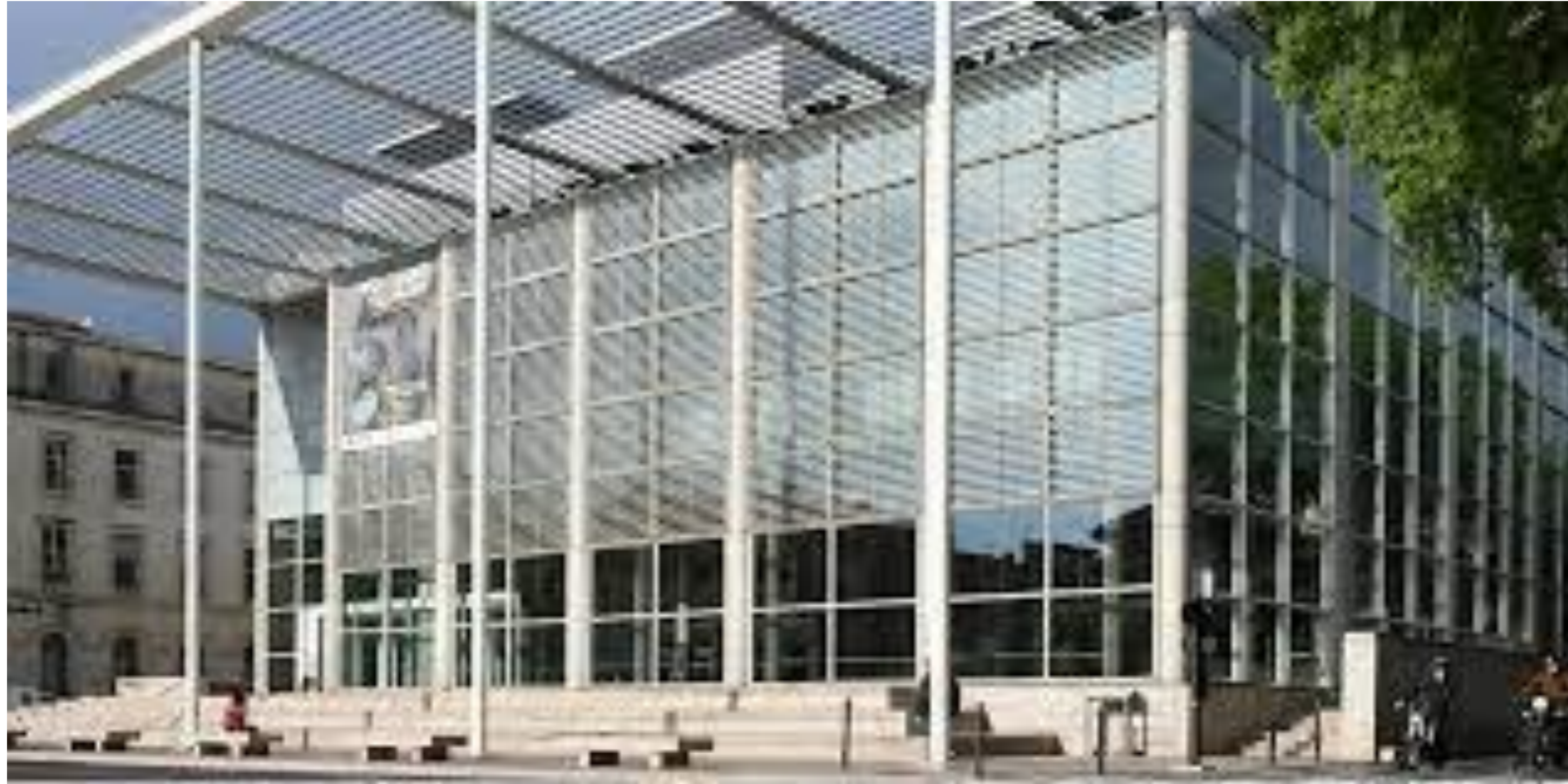
Care d'Art, Nimes, Perancis. Arsitek, Norman Foster. Penggunaan rangka struktur beton bertulang yang mendukung kulit luar yang terbuat dari kaca dan bukan merupakan elemen pemikul beban.
